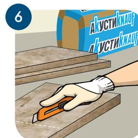
6 Отмеряем и нарезаем звукоизоляцию АкустиKNAUF. Ширина материала на 10 мм больше шага каркаса.
