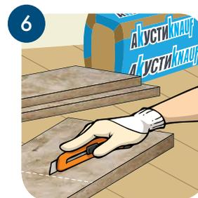
6 Отмеряем и нарезаем звукоизоляцию АкустиКНАУФ. Ширина материала на 10 мм больше шага стоечных профилей.
