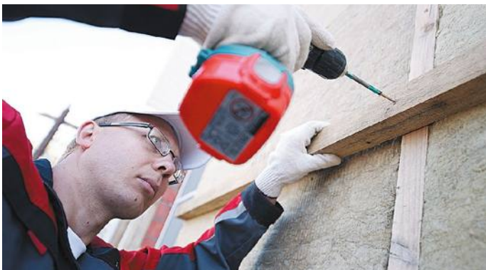
Рис. 3. Установка горизонтального каркаса
