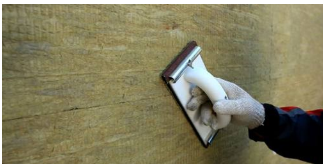
Рис. 32. Шлифовка стыков плит теплоизоляции наждачной бумагой
