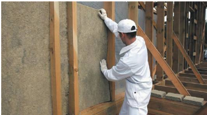
Рис. 20. Монтаж теплоизоляционных плит
