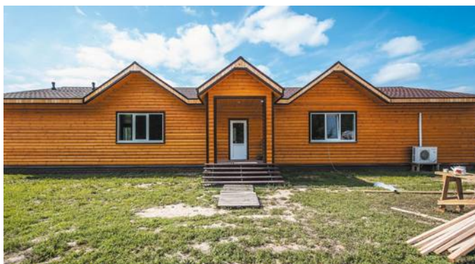
Рис. 22. Монтаж облицовочного материала
