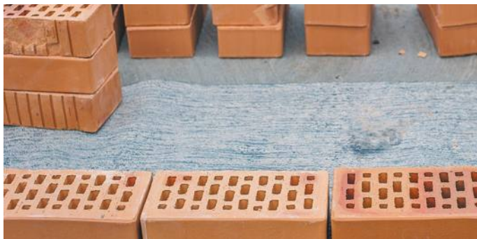
Рис. 7. Гидроизоляционная отсечка
