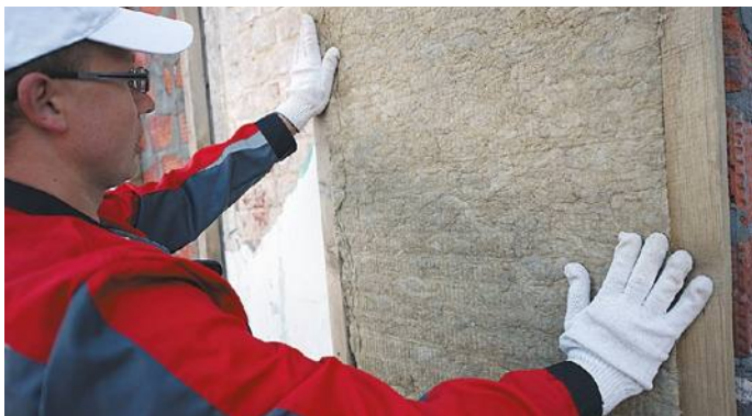
Рис. 2. Монтаж теплоизоляционных плит в вертикальный каркас
