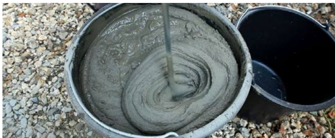
Рис. 25. Замешивание клея для приклейки теплоизоляции
