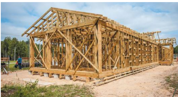
Рис. 18. Установка деревянного каркаса
