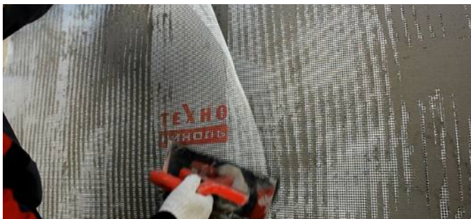
Рис. 37. Армирование базового штукатурного слоя стеклосеткой
