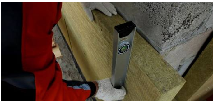
Рис. 29. Приклейка плиты тепло-, звукоизоляции к стене
