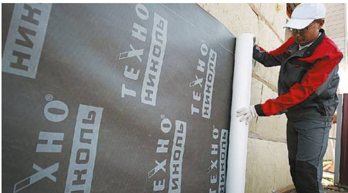
Рис. 5 а. Монтаж ветро-, влагозащитной мембраны
