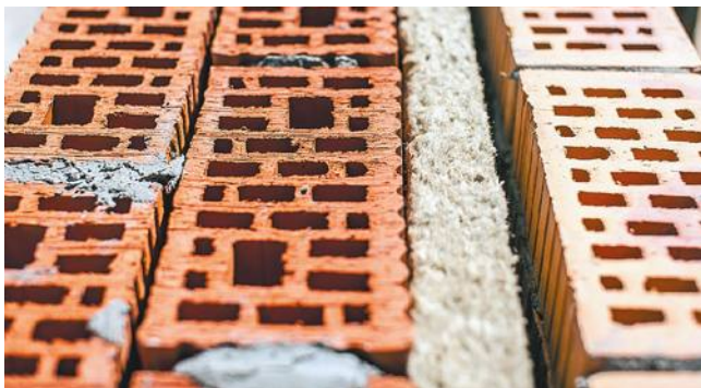
Рис. 11. Монтаж плит теплоизоляции
