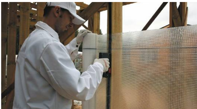
Рис. 19. Монтаж пароизоляционной пленки
