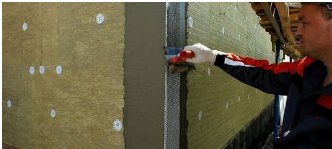
Рис. 35. Установка усиливающих профилей на углах здания
