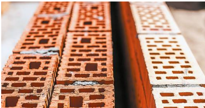
Рис. 10. Монтаж внутренней версты
