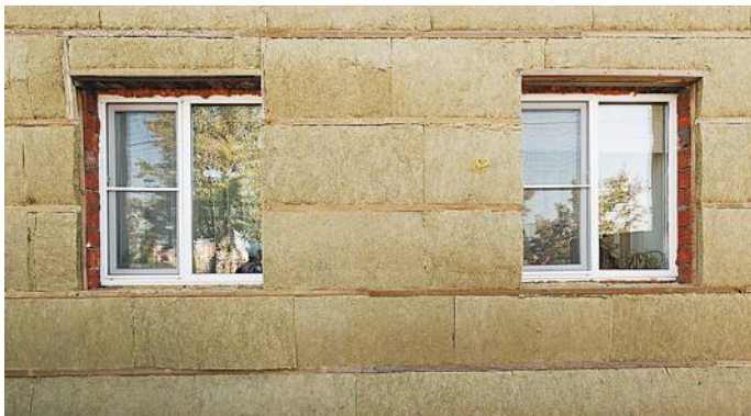
Рис. 4. Монтаж теплоизоляционных плит в горизонтальный каркас
