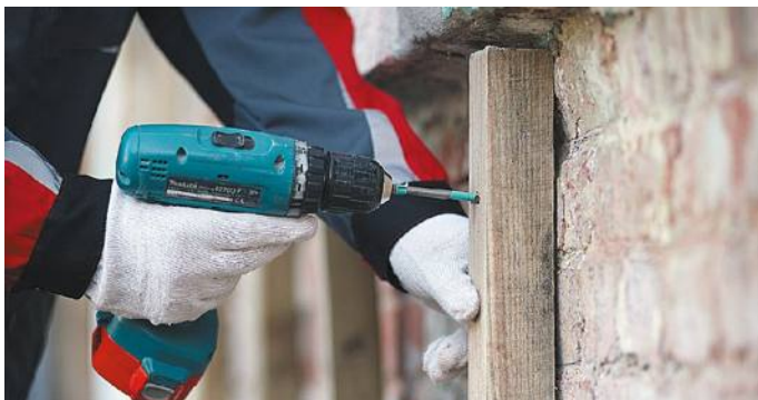
Рис. 1. Крепление вертикальных стоек деревянного каркаса
