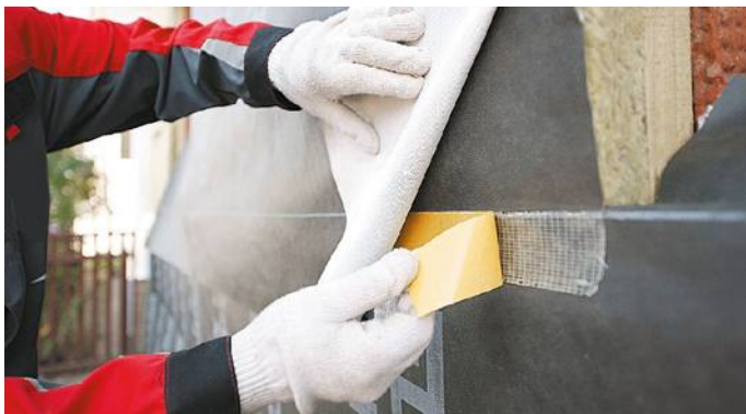
Рис. 5 б. Проклейка стыков полотен ветро-, влагозащитной мембраны
