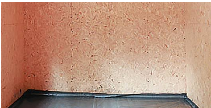
Рис. 23. Обшивка внутренней поверхности стен
