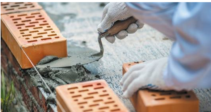
Рис. 9. Монтаж внешней версты
