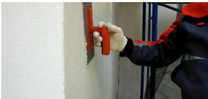
Рис. 39. Нанесение декоративного слоя штукатурки
