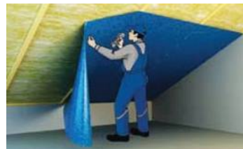
9. Монтаж теплоизоляции, пароизоляции и ОСП
