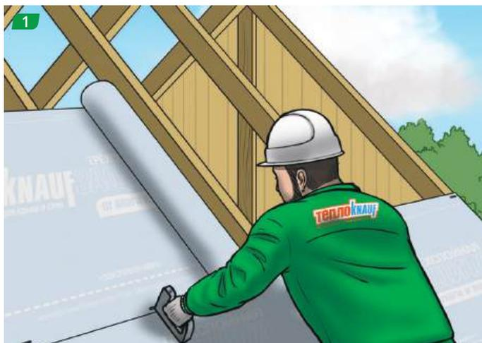
Раскатываем мембрану горизонтально вдоль нижней части стропил и фиксируем по стропилам степлером.
