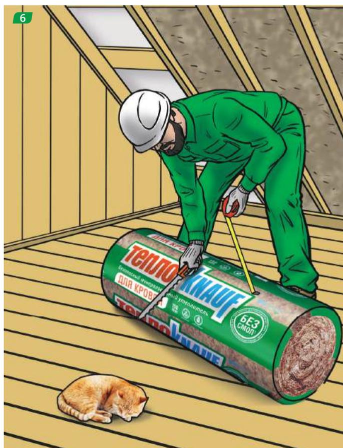
Нарезаем теплоизоляцию из расчета «шаг стропил + 10мм». Устанавливаем утеплитель между стропилами с небольшим поджатием. Толщина теплоизоляции равна толщине стропил.
