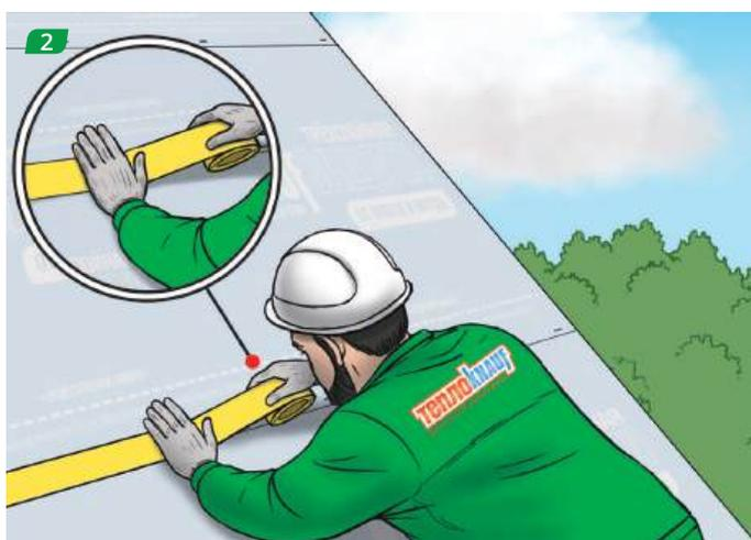
Каждый последующий слой - выше предыдущего, нахлест в 10-15 см. Стыковка мембраны в районе конька - внахлест. Стыки и места крепления степлером проклеиваем лентой для заклейки швов.
